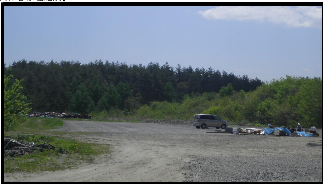
【鳥居地区漁具保管修理施設】
