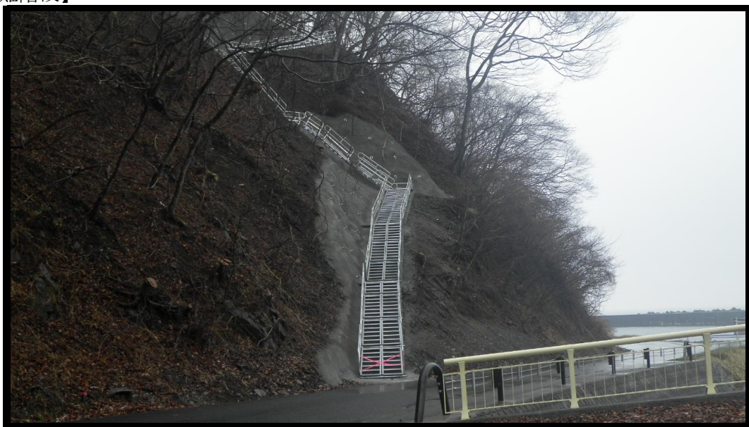
【堀内地区避難階段】
