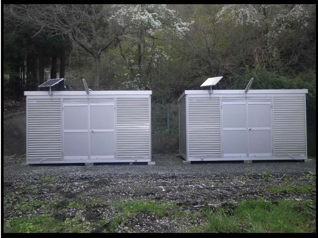
【中学校防災備蓄倉庫】
