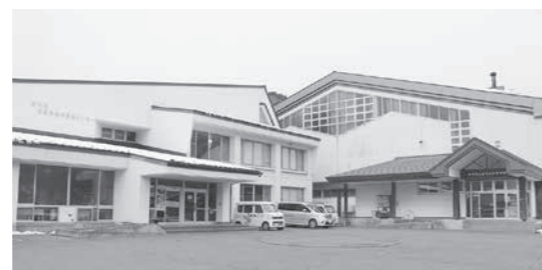
補強されながら使用される予定の管理センター・社会体育館
