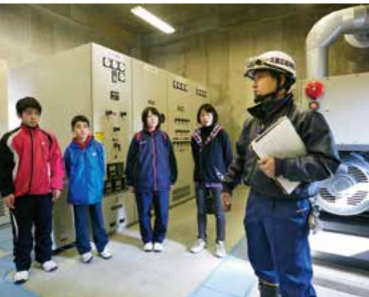
津波が入り込んだ建屋内で説明を聞く生徒たち
