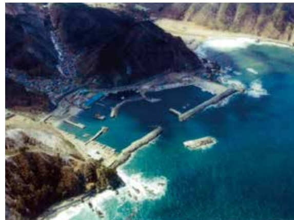
上空から見た普代村沿岸部(平成23年3月28日)
