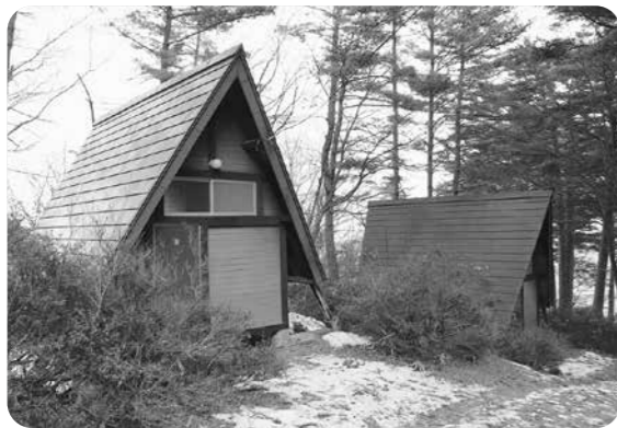
解体されるバンガロー
