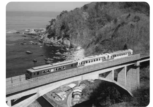
三陸鉄道 堀内大橋から
