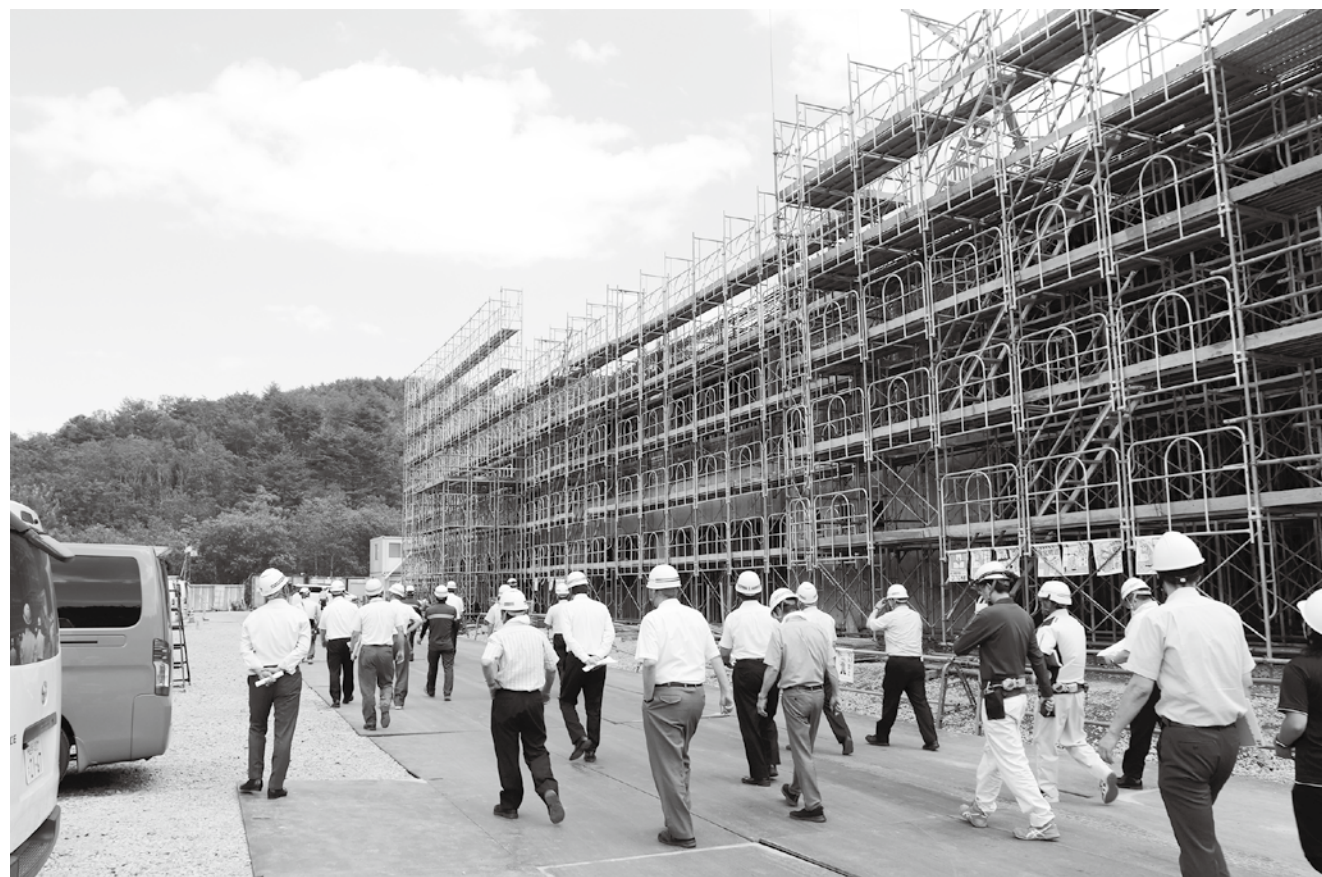
建築工事中の普代学園（校舎棟）
