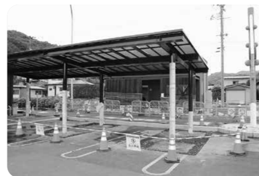
トイレや駐車場の工事が進む普代駅
