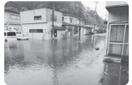
過去の冠水の様子。排水ポンプの設置によって解消される
