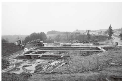
工事が進む給食センター（鳥居地区）
