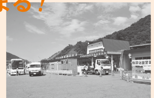
11月の営業を目指し、増改築工事が始まった普代駅
