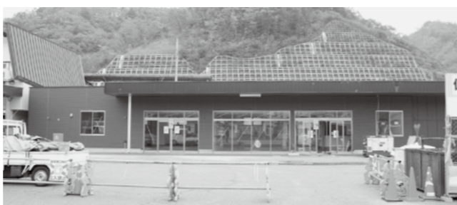
内装工事が行われている普代駅舎(10月31日)
