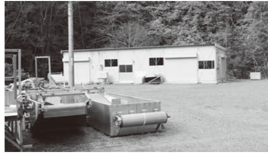
撤去予定の仮設施設（太田名部大沢地区）
