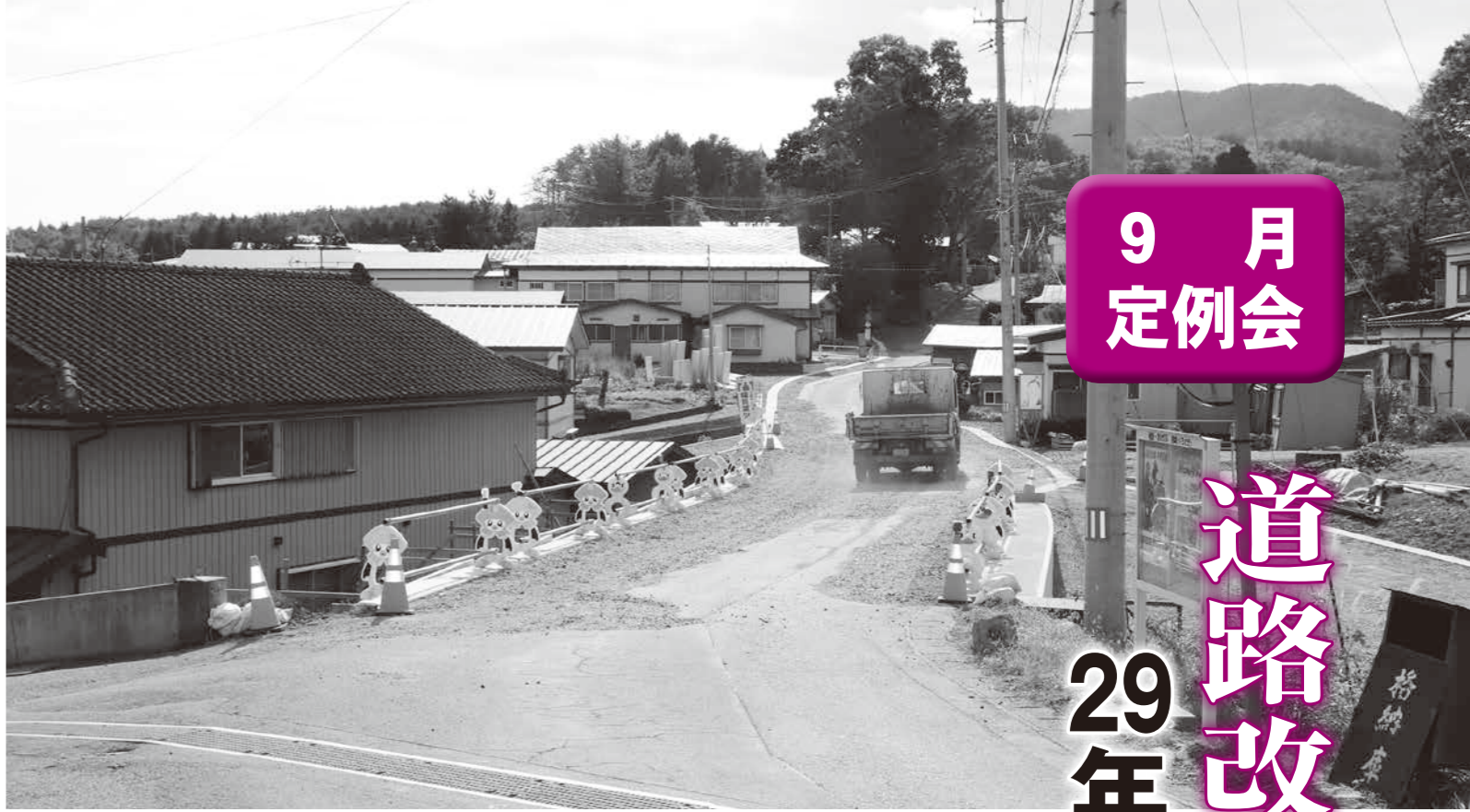
改良が行われている村道黒崎港線
