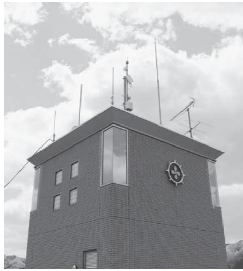
役場屋上にある地域通信基盤アンテナ
