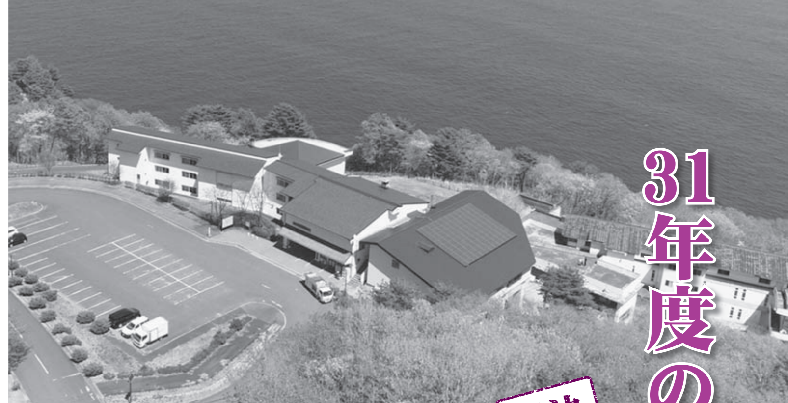
国民宿舎くろさき荘上空（ソーラーパネルの屋根右側にある別館は国立公園利用拠点整備事業にて解体予定）
