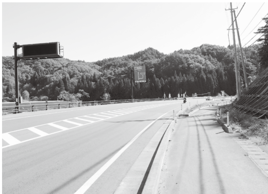
今後、国道45号と三陸沿岸道路の切り替え工事が行われる力持付近
