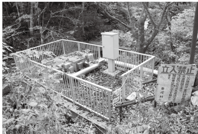
堀内簡易水道
