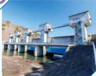
1972年着工1984年完成総工費35.6億円、総延長205m高さ15.5m。水門4基(ローラーゲート式)、陸閘2門(引戸式)はいずれも消防分署から遠隔操作で開閉する。越流はしたが、威力を削がれた津波が民家を襲うことはなかった。そばには、建設に尽力した元村長の顕彰碑が建立されている。
